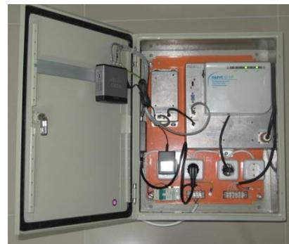
Рис. 6. Полевой пункт системы СССМ для наземной установки
