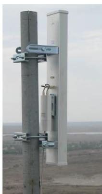
Рис. 8. Точка доступа центра беспроводной сети связи СССМ
